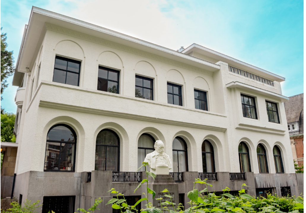
Bâtiment de l'IEE, avenue Franklin Roosevelt 39-41
